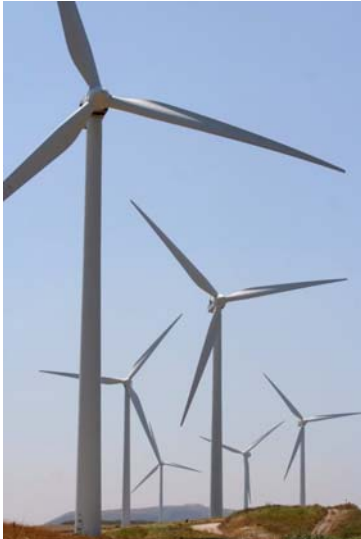
Figure 4 - Éolienne du Sud Est de la France
