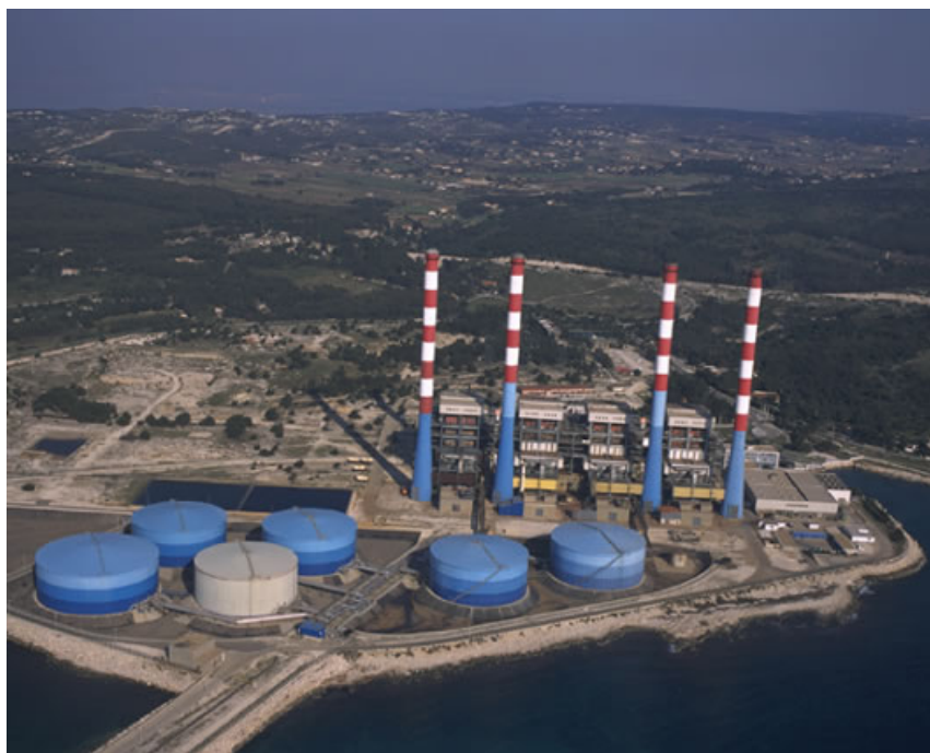
Figure 2 - Centrale thermique de Martigues-Pontéon
